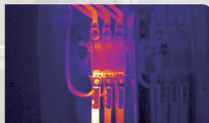
Conexão Solta
